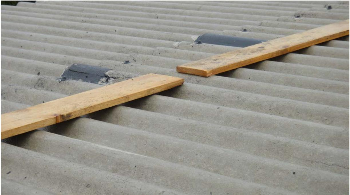
Schritt 1: nach der Druckwasserreinigung das Dach auf Schäden untersuchen
