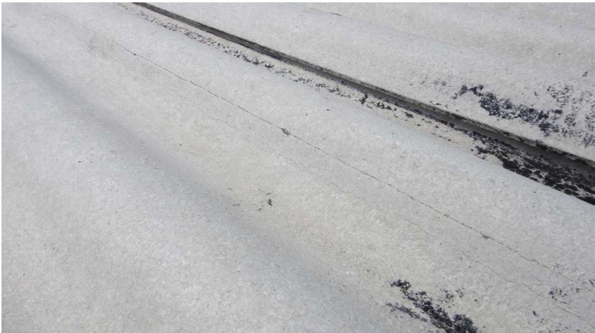
Schritt 2: Ausschäumen der Fehlstellen und Plattenfugen
