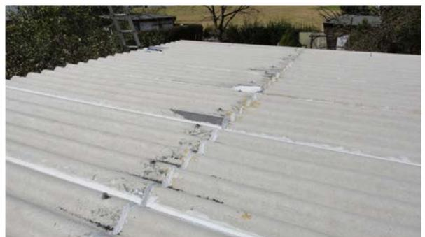
Schritt 3: zur Verfestigung der Fasern werden die Platten mit PURGRUND-S grundiert. Dieser Schritt ist notwendig, um die je nach Grad der Alterung faserige Oberfläche für die weitere Beschichtung tragfähig zu machen.
